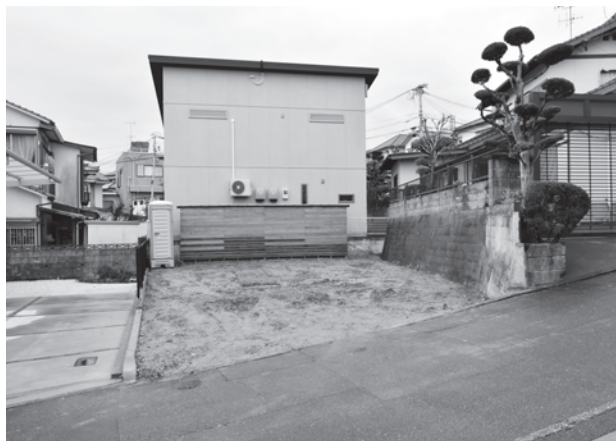
7. 調査前全景 (北から)
