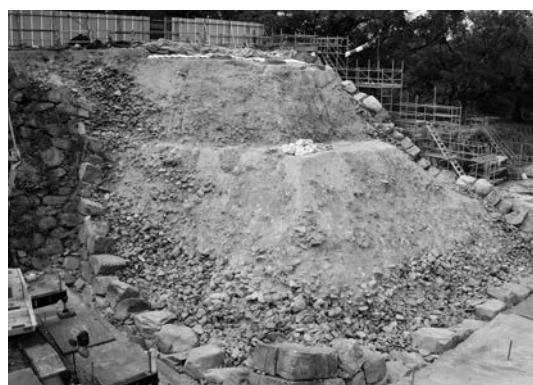
2. 石垣の解体状況 (南東から)
