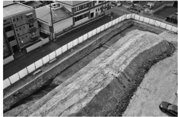
1区西半全景（北東から）
