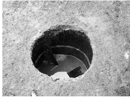
15. SE38 井筒 (東から)
