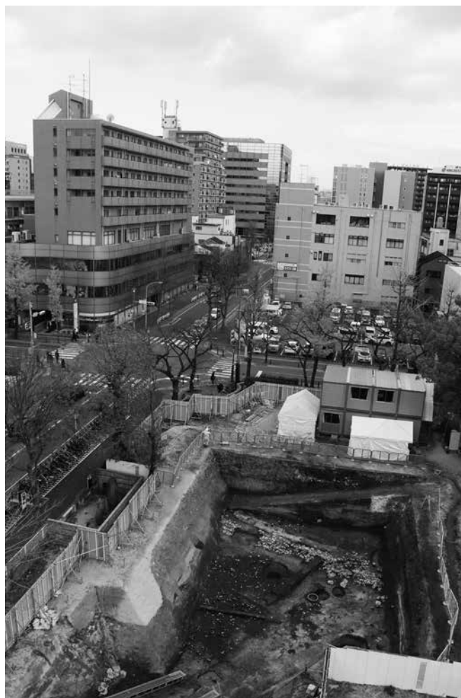
1. Ⅱ区第2面と遠景 (西から)
