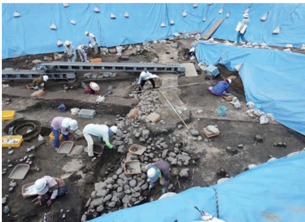
8. II区石積遺構検出風景（南から）
