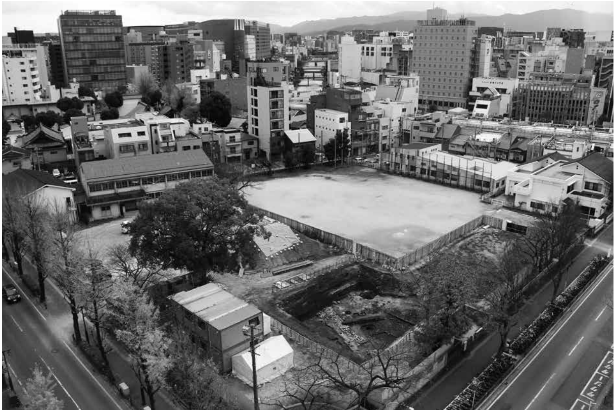
1. Ⅱ区第2面遠景 (北東から)
