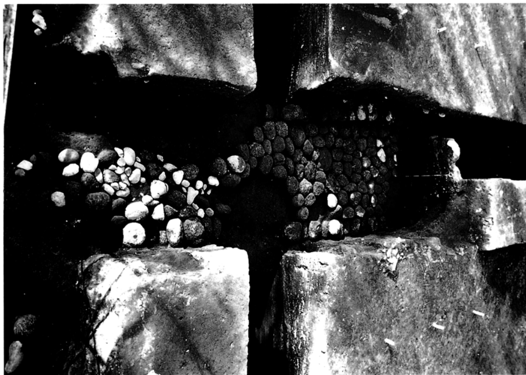
横穴式石室の状況（南より）
