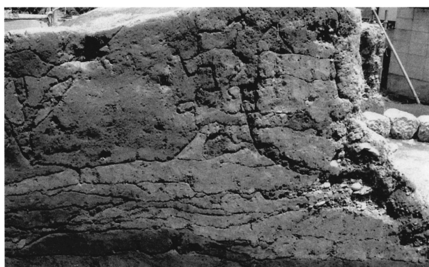
東西土層断面西側 (D-E) (南西より)
