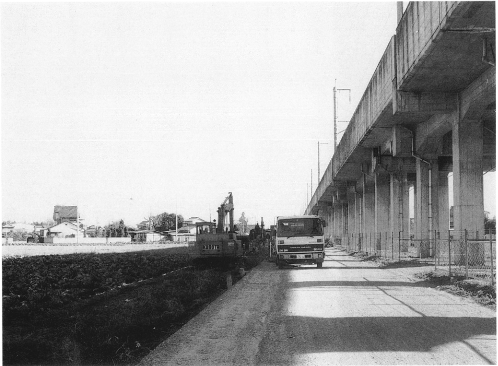
2. 発掘調査状況（重機による表土剥ぎ）
