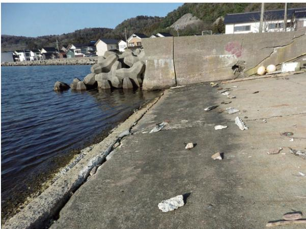
⑤真脇遺跡直下の高倉漁港（西側：能登町姫） 護岸に亀裂が入り、コンクリ片や木片が散乱しており、津波の痕跡がうかがわれる。
