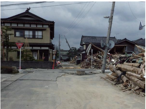
⑤丈六山妙巖寺門前（珠洲市宝立町鶴飼）液状化によりマンホールは突き出し、道路奥の寺の山門は崩落している。路面には津波堆積物の砂が広がっている。
