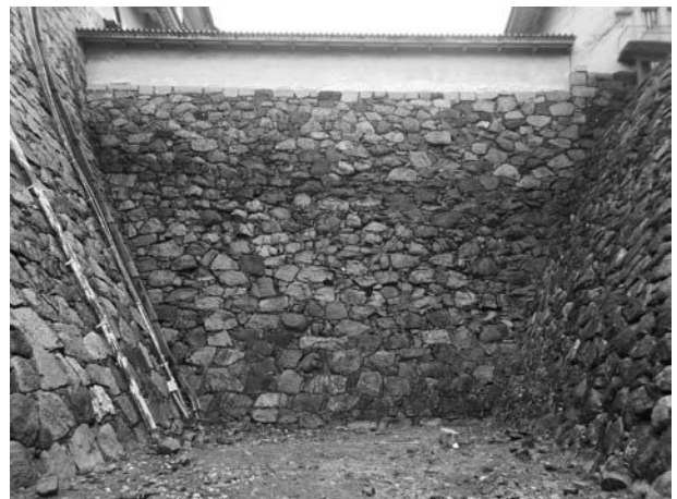
写真5 橋台西面 (U 58) 石垣
