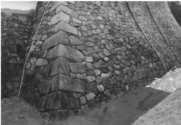
写真1 大天守台北面（U 61）石垣
