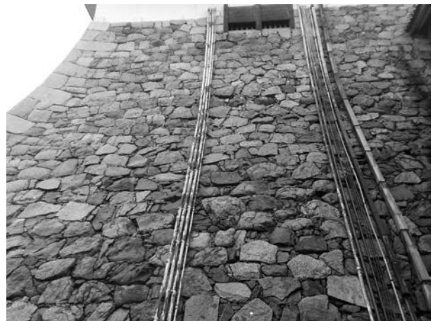
写真3 大天守台南面（U 59）石垣西部
