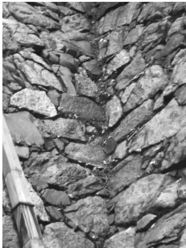
写真8 大天守台南東入隅 (U 59- U 58 間) 上半
