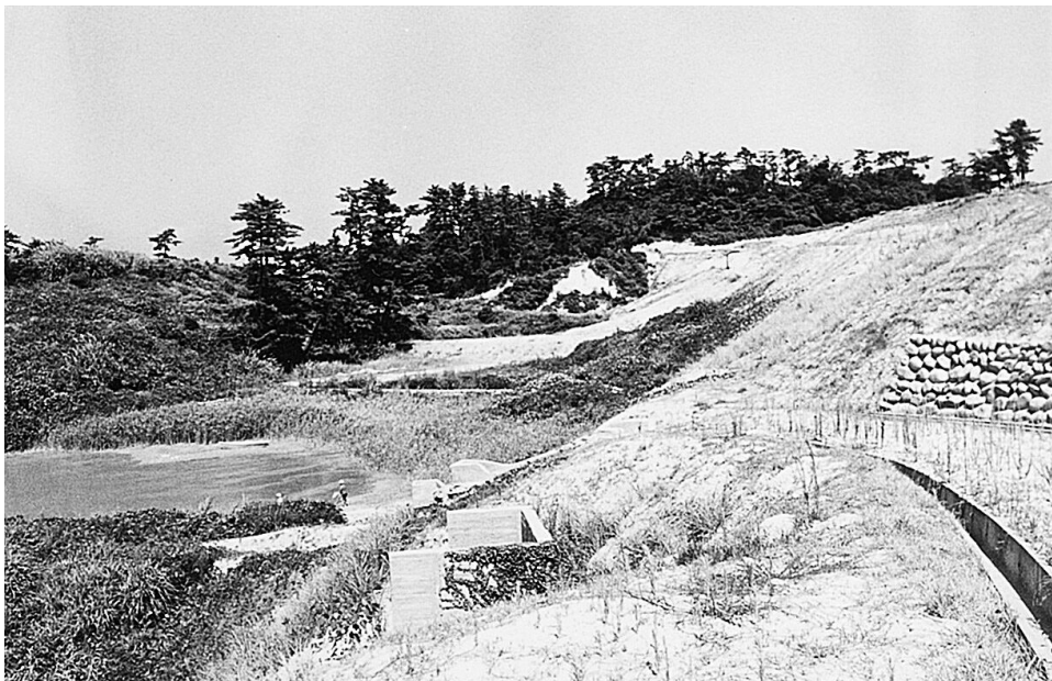
図4 大野城跡 青海台団地造成中、土木作業員が写っている。復原建物風展望施設はまだ建てられていない。 服部英雄『昭和三十年代 濃尾平野周辺の中世城館』より
