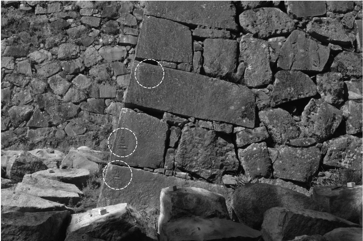
写真6 本丸東二之門櫛形張出南東角／東から
