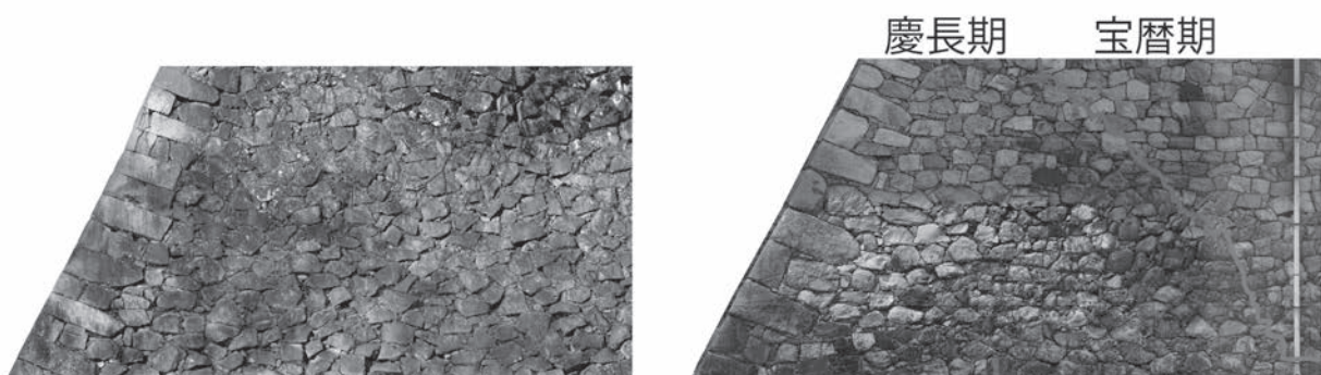
図9 左：二之丸148N石垣(前田家) 右：本丸U61H(010H)石垣(肥後加藤家、線より右側は宝暦期の積み直し)(縮尺不同)
