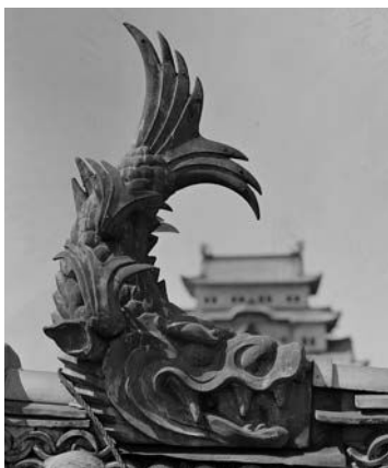
ガラス乾板 125-03-09 東北隅 櫓銅鯨 (南方)
