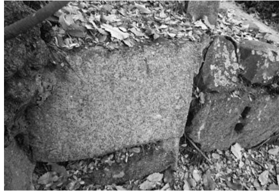
图13 文化二年石垣修理碑現況
