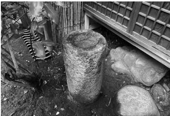
7 : 紙屋川橋杭 (南東から)
