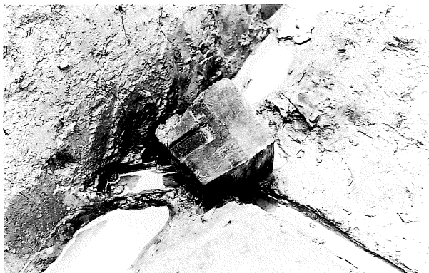
3 D区第7号溝跡埋設管接続部
