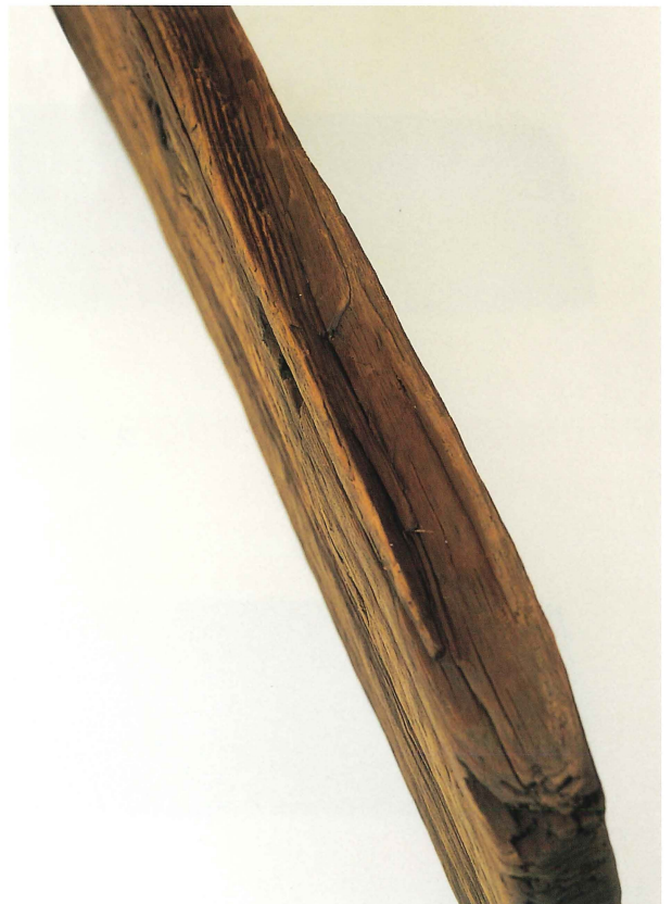
4 樋部倉矧壁板 側面部V字谷形加工
