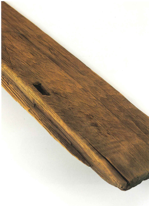
3 樋部倉矧壁板 側面部V字谷形加工
