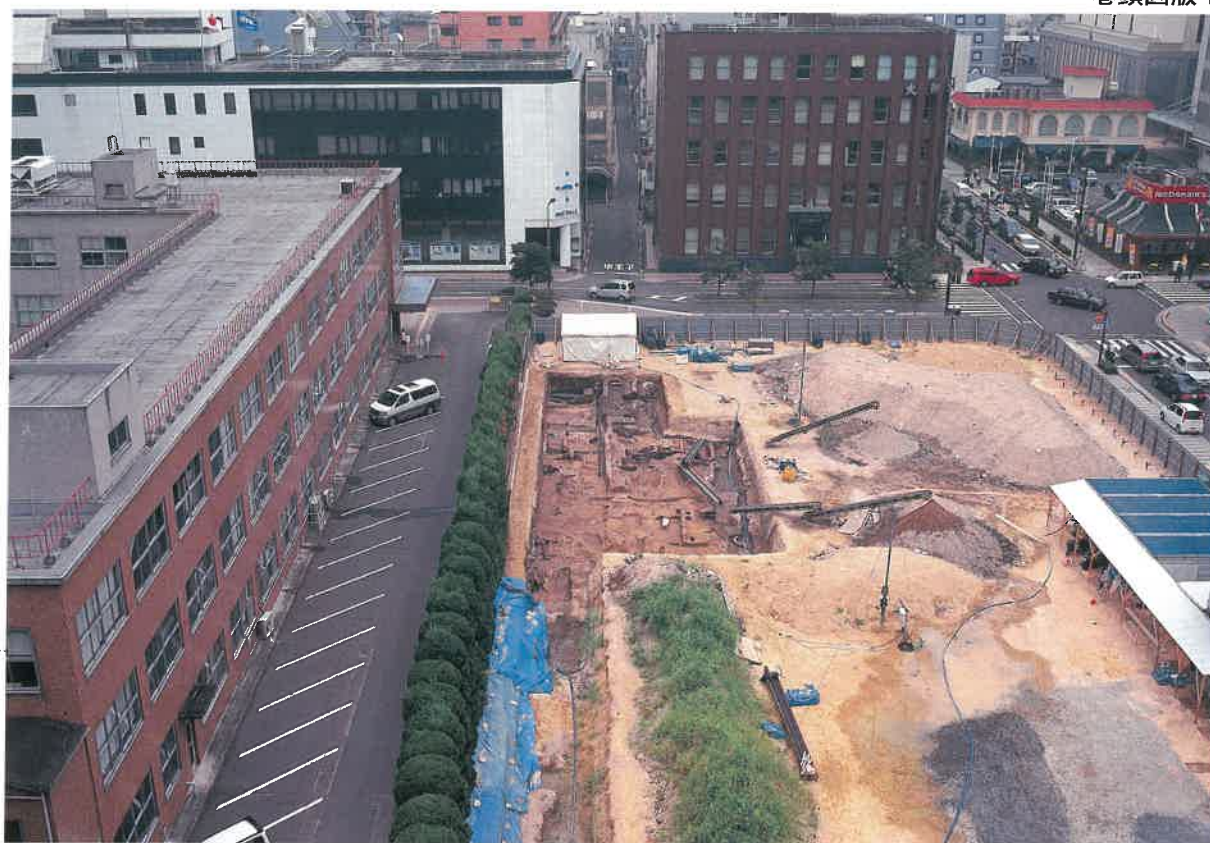
調査区遠景（西より）
