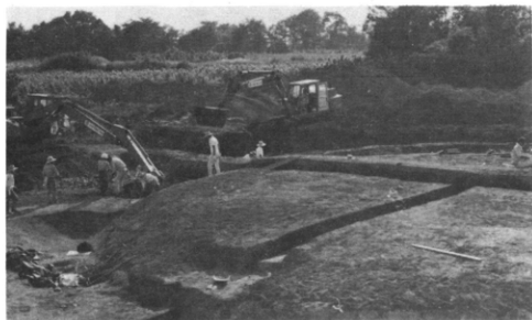
写真1 重機による発掘調査風景
