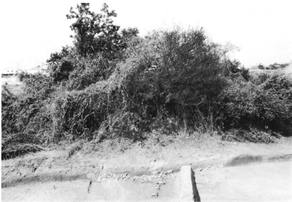
2 第5号墳近景（南より石室掘り方方向を望む）
