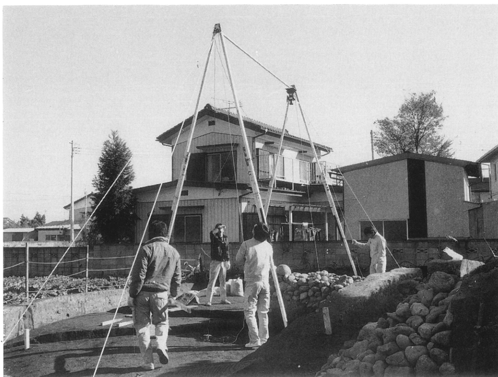
2. 石室写真測量風景
