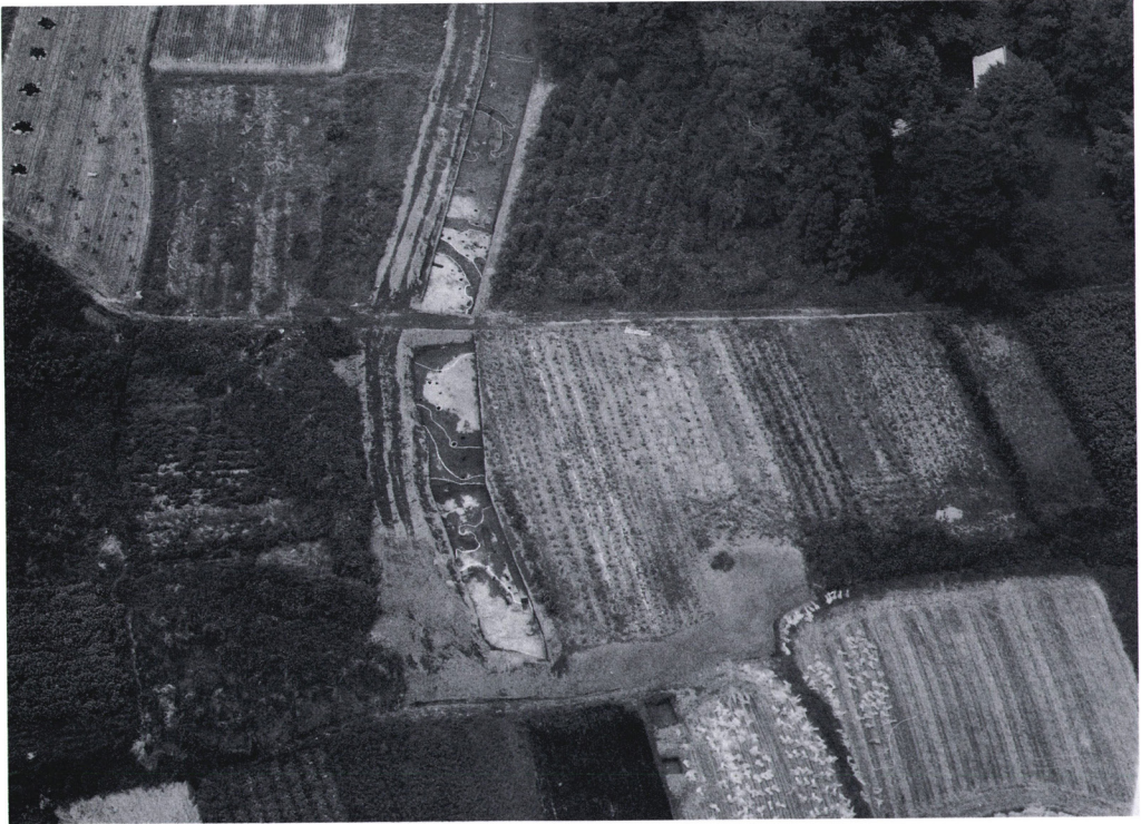
1 導水路地点航空写真
