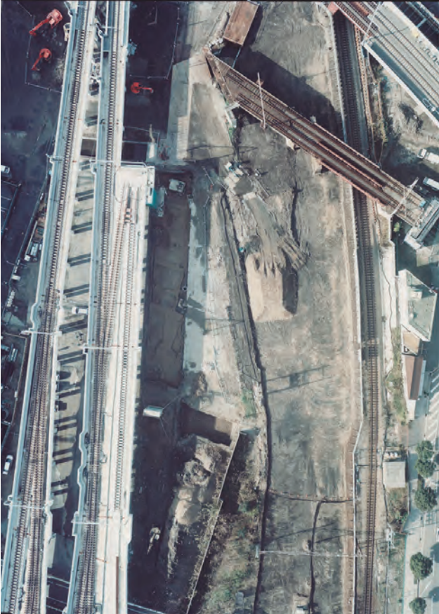
1. 1区・2区全景 (上から)
