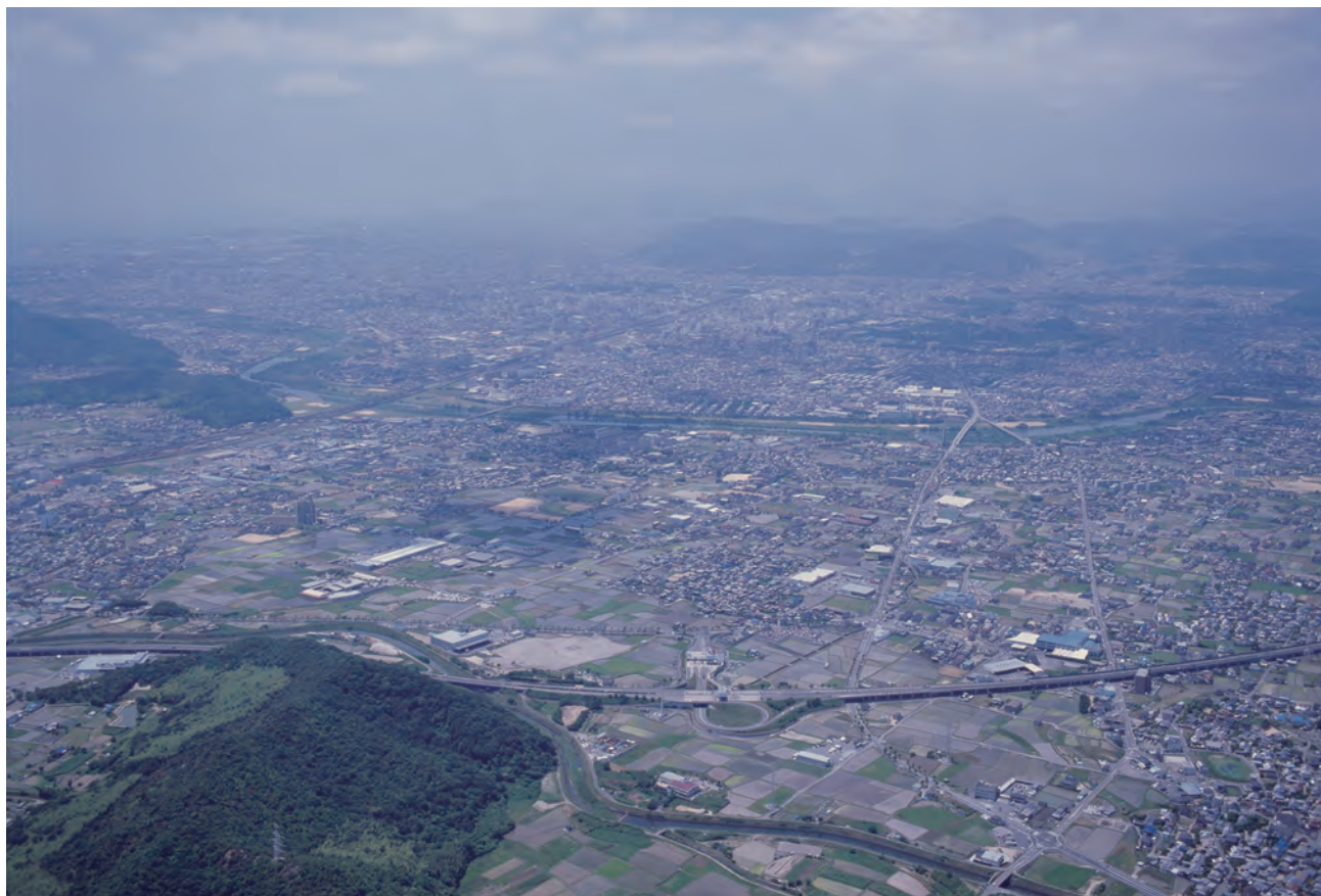
1. 姫路市街地遠景（北東から）
