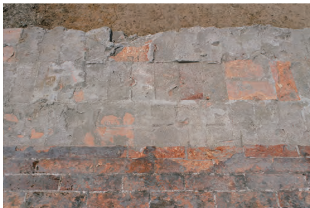
4. 煉瓦遺構A細部 (北から)
