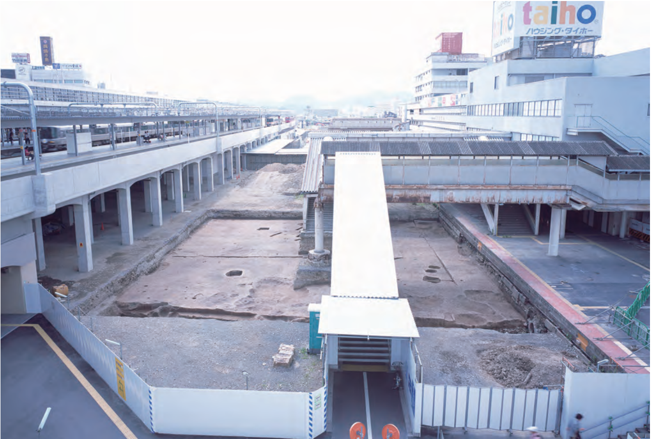
1. 調査区東部全景（東から）
