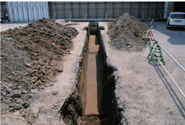
3. 下水道部分先行（西から）
