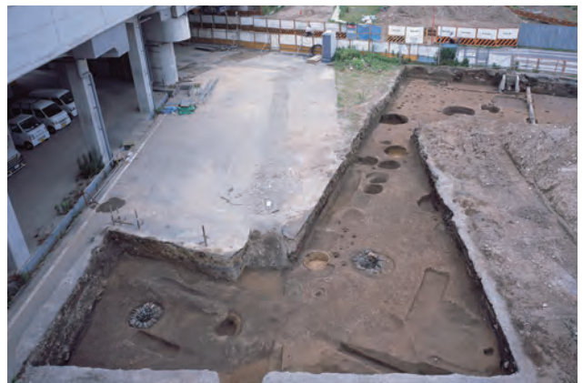
4. 調査区東部全景 (東から)
