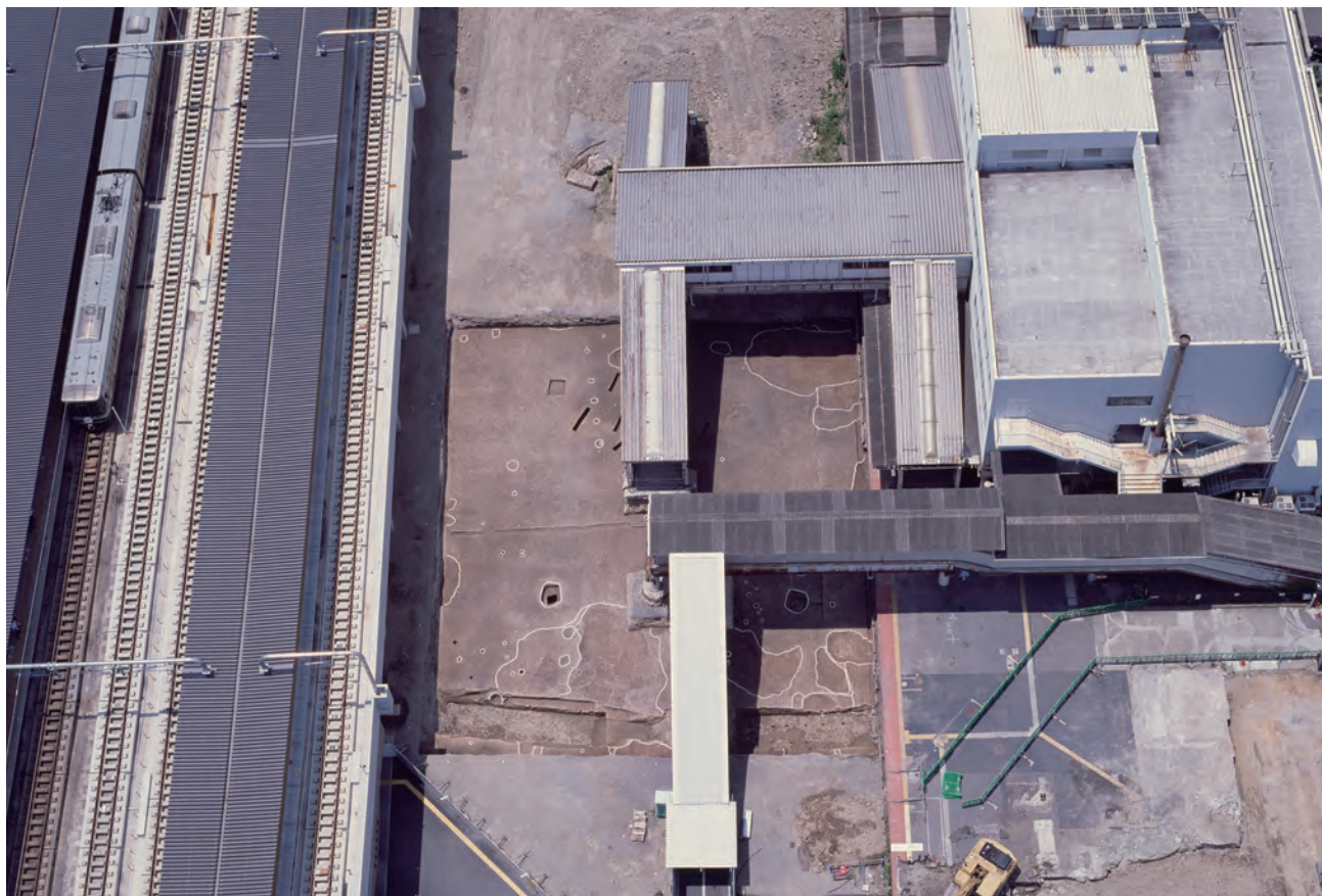
1. 調査区東部全景（東から）
