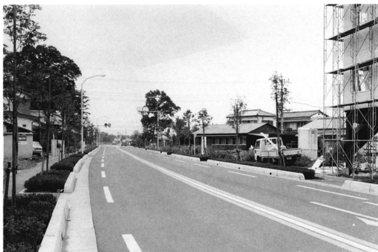
開通した都市計画街路南大通り線(栄地区)
