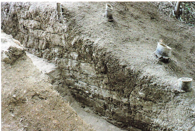
■版築土塁 土を何度も突き固めることで強固な壁をつくる「版築」という大陸伝来の土木技術を使ってつくられた土塁です。
