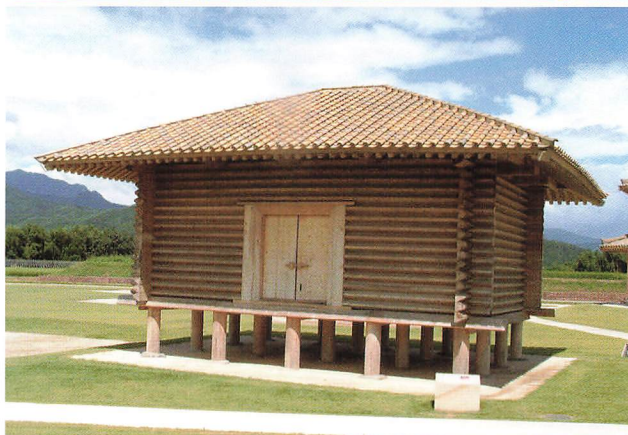
■上：20号建物跡、下：20号建物跡を復元した米倉 鞠智城Ⅳ期の建物で、3間（7.2m）×4間（9.6m）の礎石建物です。この時期には、同規格の建物が規則正しく配置されています。
