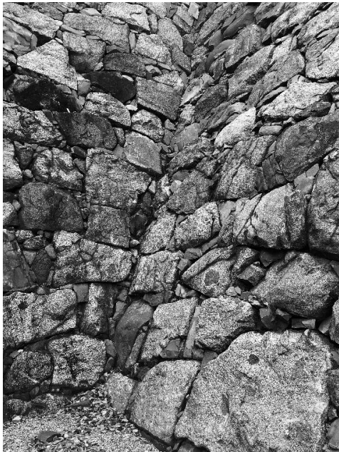
写真1 大天守と橋台東面入隅部 (右：大天守南面、左：橋台東面) すべて大天守南面が先に築かれる
