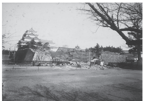
15 宮内庁所蔵本丸西南隅櫓台修理写真
