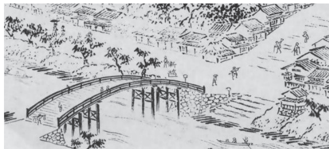
3 小治田之真清水（尾頭橋）ともに橋脚は川の中央を開ける。
