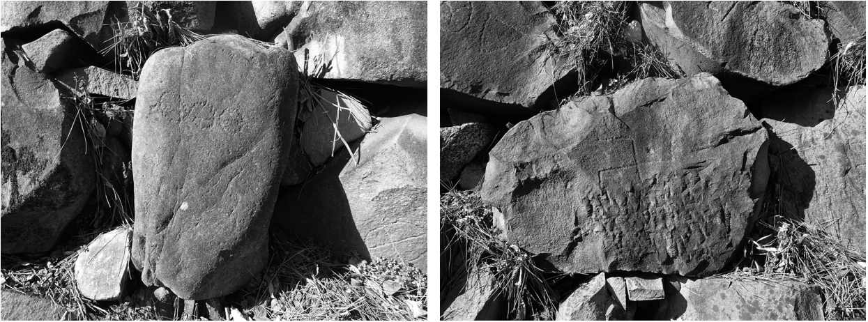
図3 築石部における自然面（左）・割面（右）（135N石垣）
