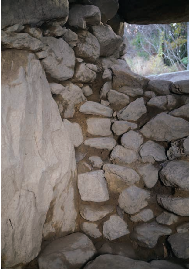
(3) 12号墳玄室左側壁玄門側（南東から）
