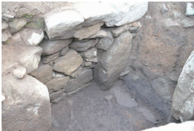
(1) 17号墳前室右側壁（北東から）
