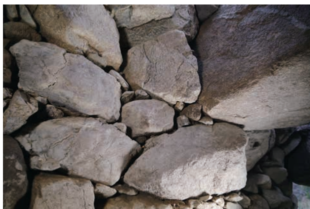
(3) 12号墳前室右側壁上部（北から）
