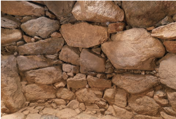
(3) 12号墳玄室左側壁玄門側（南東から）
