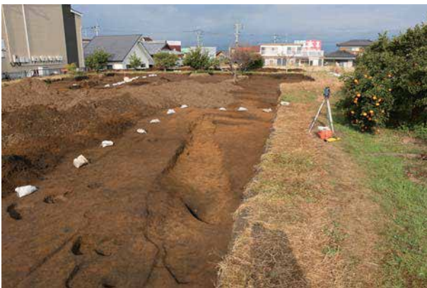
(4) SD 36 完掘状況 (南東から)
