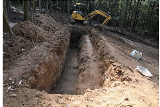
(2) 1号墳東トレンチ掘削状況(東から)
