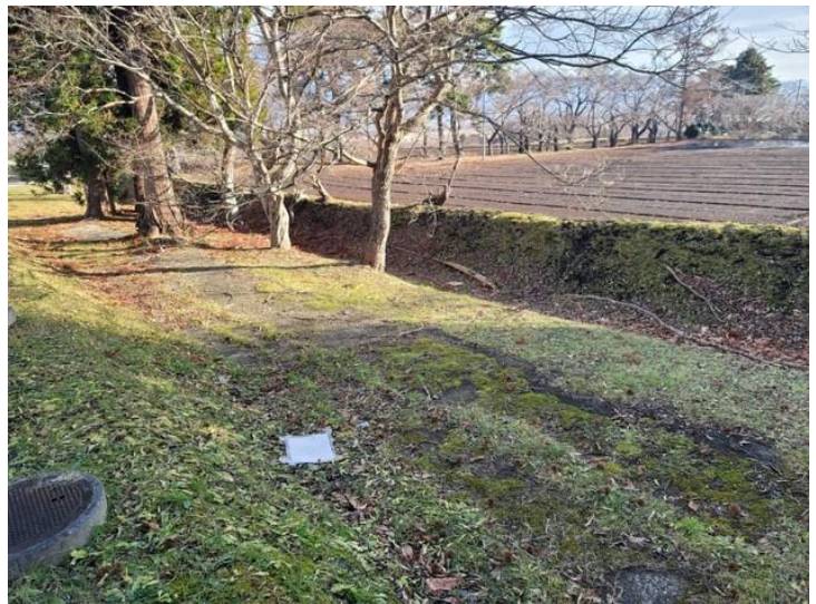
図 46. 現史跡境界に現存する戸切地陣屋の文久期土塁（画像中央を横断する土塁が該当する。西から撮影）
