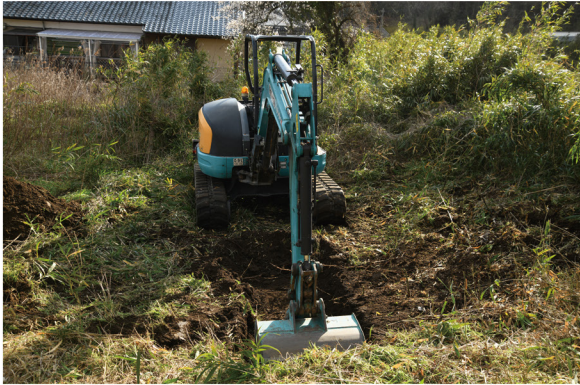
3. トレンチ掘削状況
