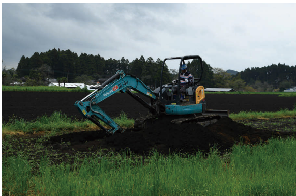
3. トレンチ埋め戻し状況
