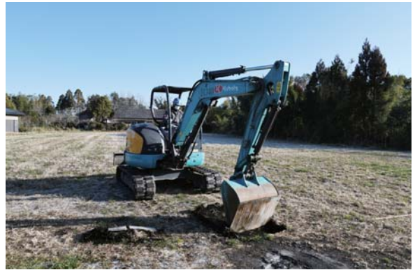
2. 表土除去状況
