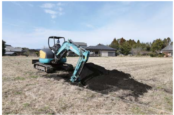
6. 埋め戻し状況
