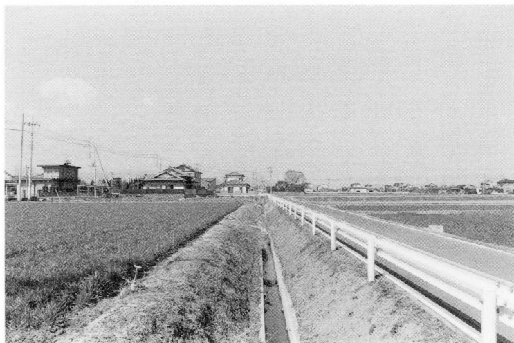
排水路（蛭川地区）東から 47
