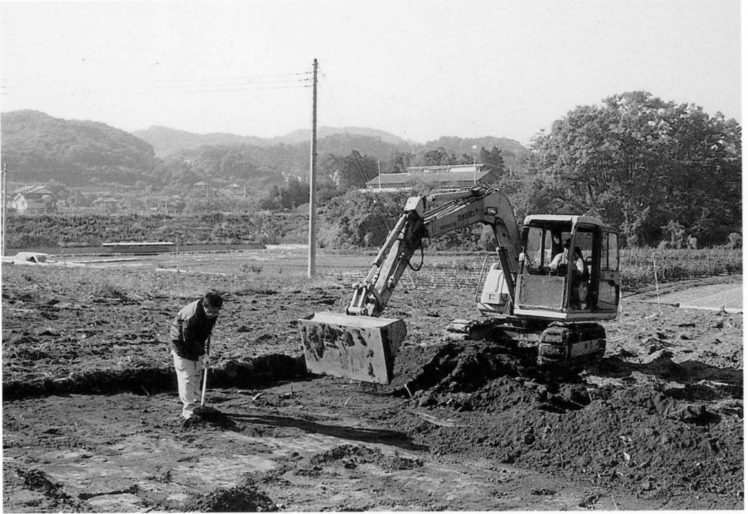
1. C地点 表土除去
