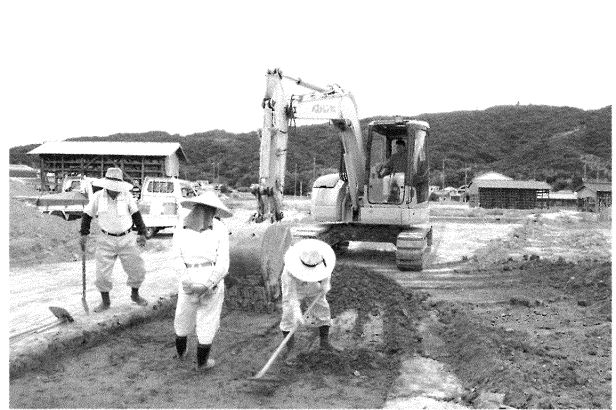
3. 3区重機作業風景(4次調査・東より)
