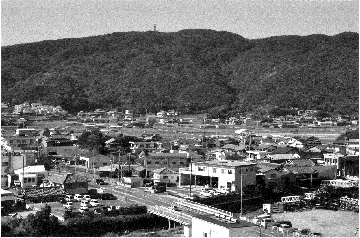
1. 調査地遠景(南東より)
