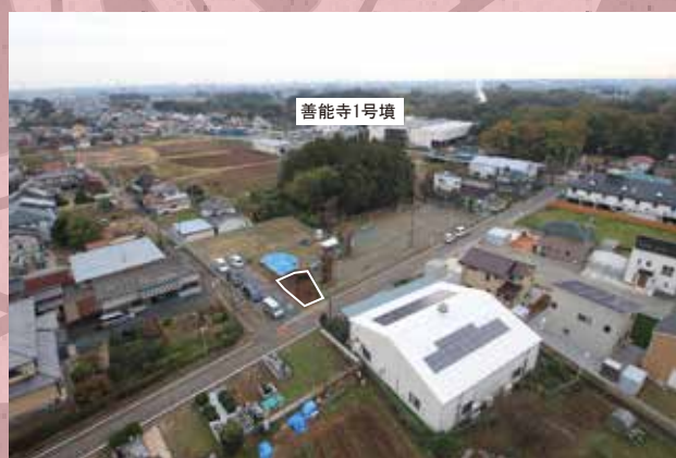
調査区周辺 (空中写真撮影)
