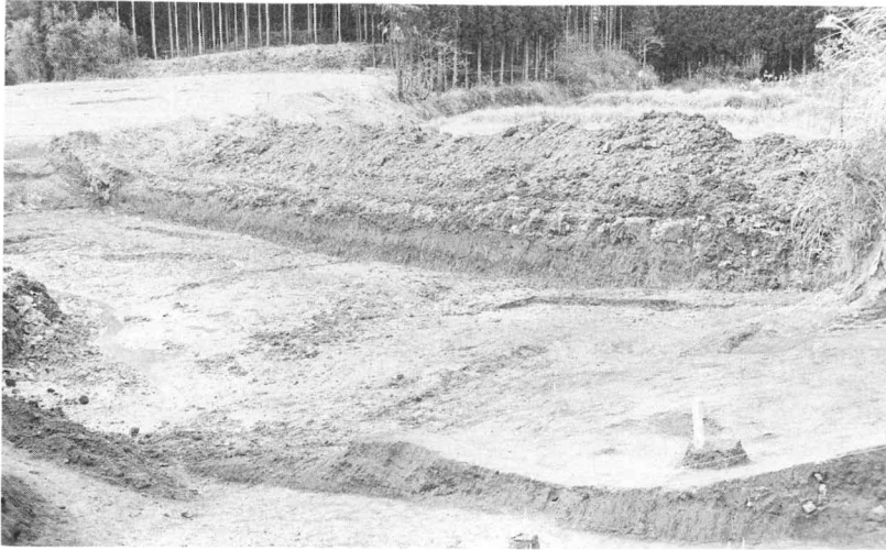
図版-22 袖ノ木元調査区 土層断面 (南東から)
