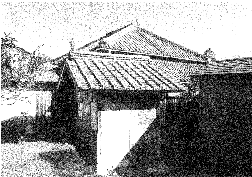
31 修理前 同上、手前は風呂場棟
