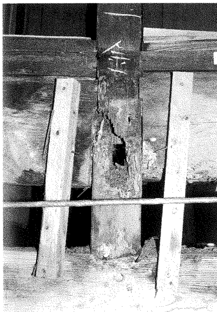
93 破損状況 柱、足固めの腐朽状況
