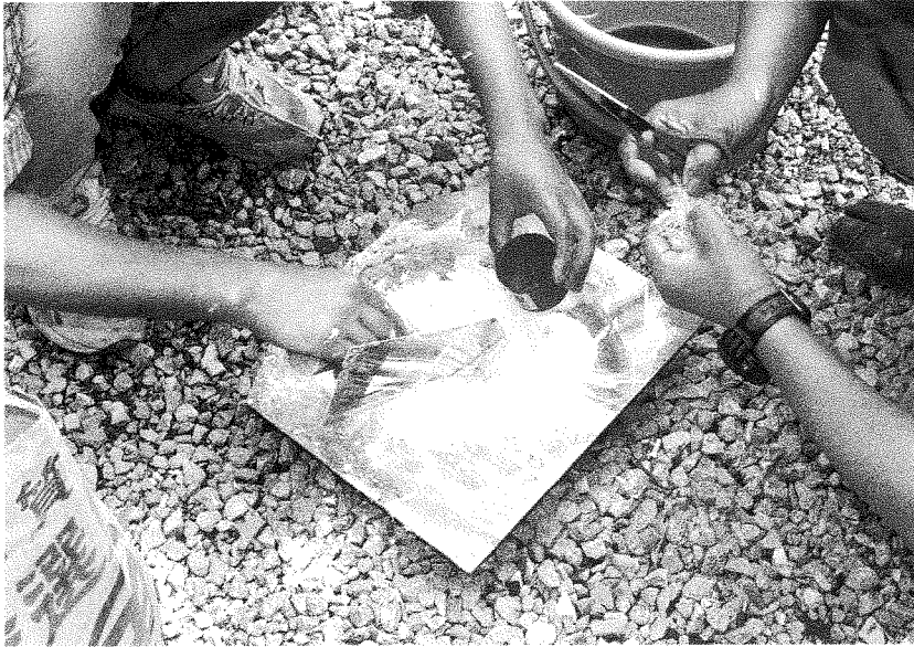
77 工事中 左官工事 しっくい試験練り
