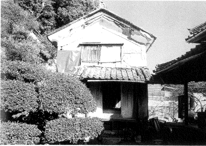
121 修理前 土蔵 正面（南）外観
