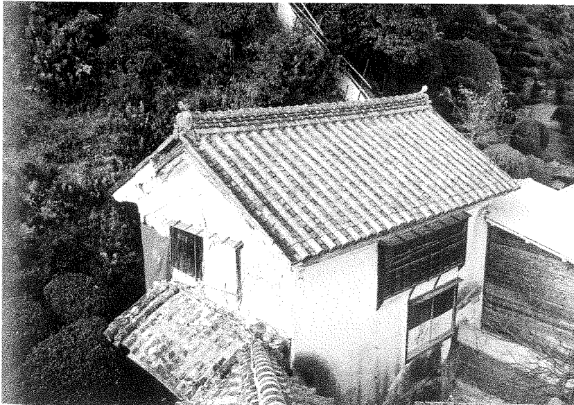
123 修理前 土蔵 外観 屋根面
