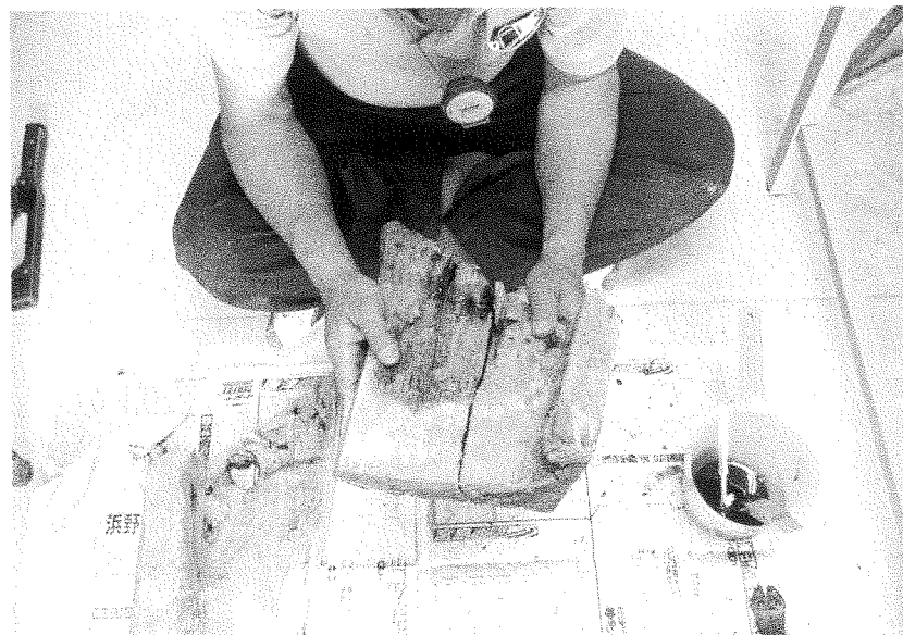
97 破損状況 谷樋受先端部品の破損
