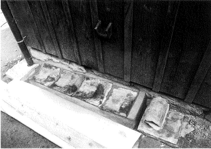
83 工事中 外 構 台所外部の排水路と縦樋
