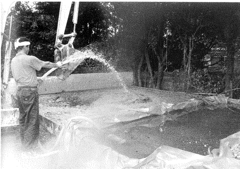
52 工事中 土 拵え 再生土の水張り 溜置の水で注水した
