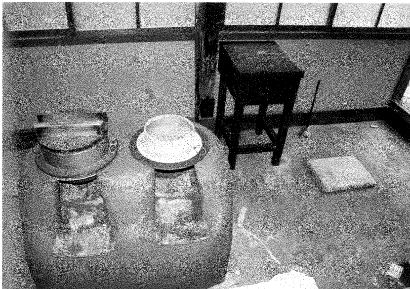
81 工事中 左官工事 台所内釜戸完成 土間は三和土叩きで仕上げる
