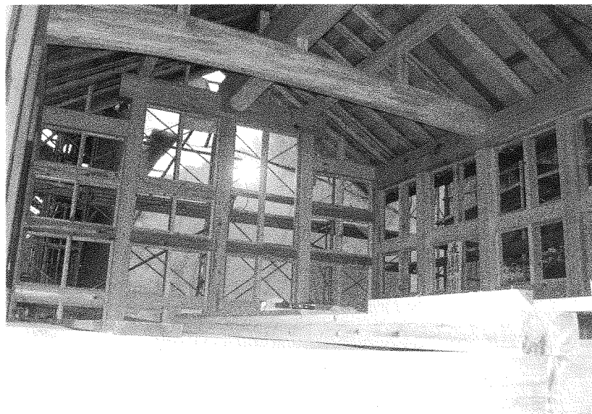
132 工事中 土蔵 木 工 事 軸組小屋組完了
