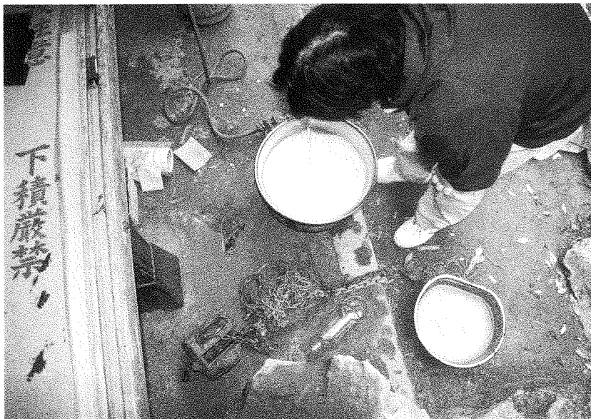
78 工事中 左官工事 壁用のワラビノリを炊く
