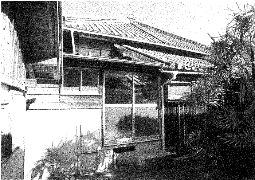
30 修理前 南面外観
