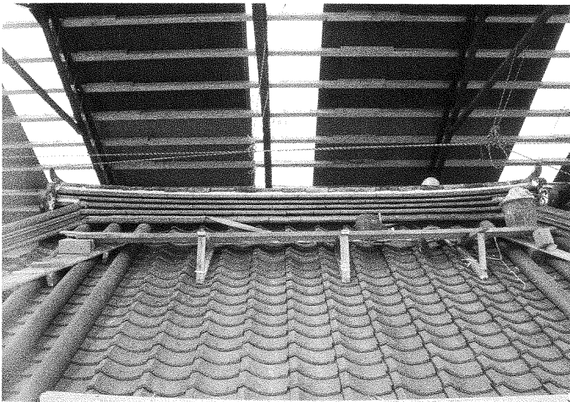
69 工事中 屋根工事 棟納り完了
