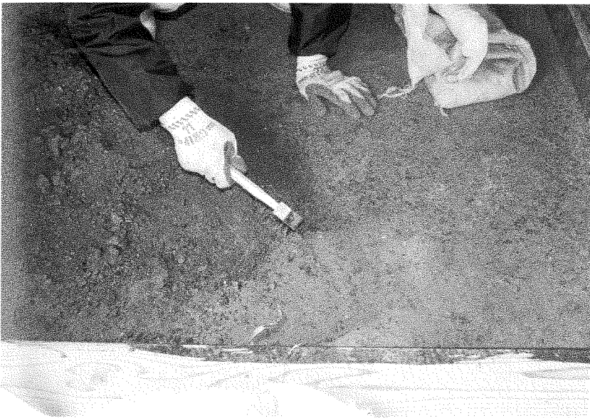
63 工事中 土間叩き 玄関土間部は表層をはぎ取り、新 土と混練し叩き締めた
