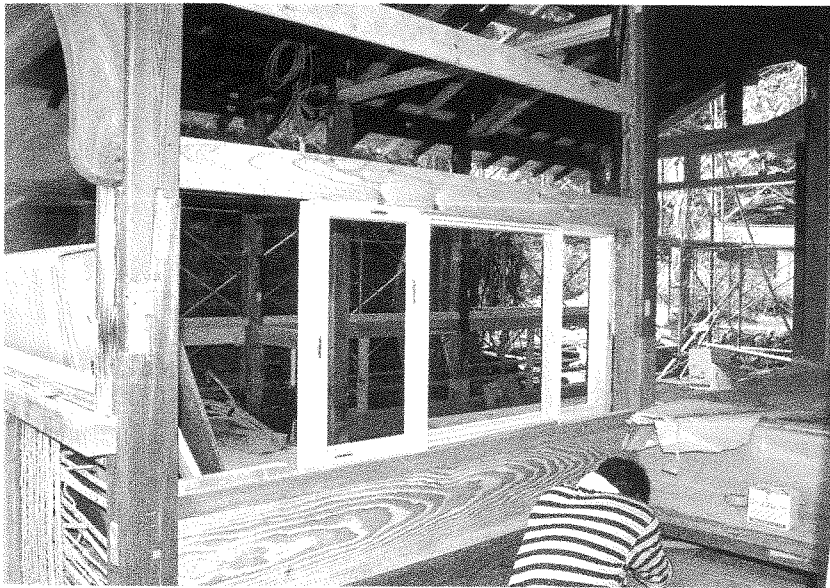
57 工事中 木 工 事 新設窓の取付 足固めの取り替え
