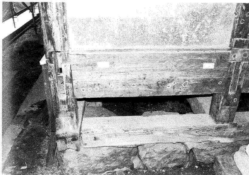
106 現状変更資料 寢間外部（は）通りに残る足固め 等の痕跡と土台肩に残る根太掘り 痕跡。延長されていた
