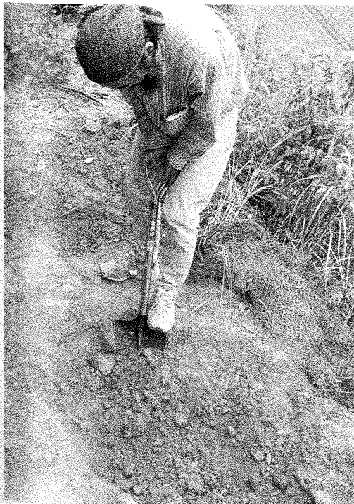
76 工事中 左官工事 赤色土の採取 佐伯市波越地区で
