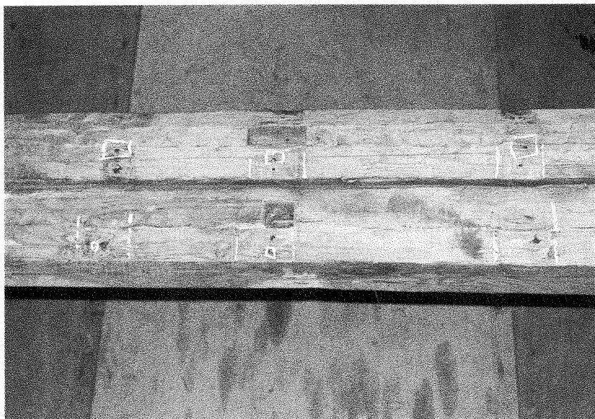
136 技法資料 棟木、母戸に残る釘跡 和釘での一回盛替え跡が見られる
