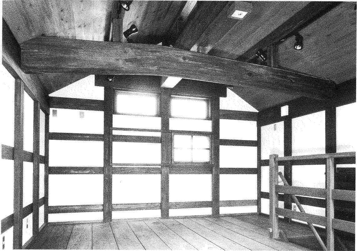
17 竣工 土蔵二階室内
