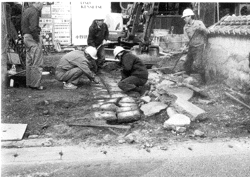
87 工事中 庭 工 事 進入口伝いの整備
