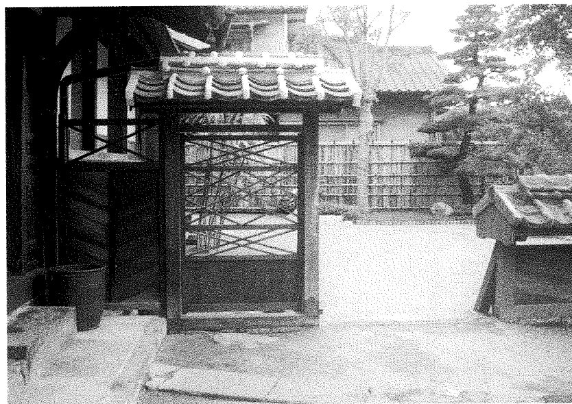
20 竣工 中木戸門
