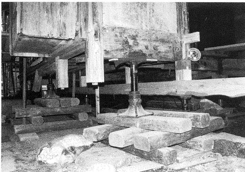
49 工事中 揚屋工事
