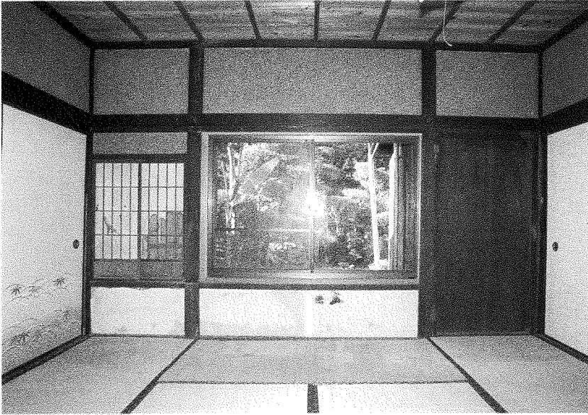
35 修理前 次の間
