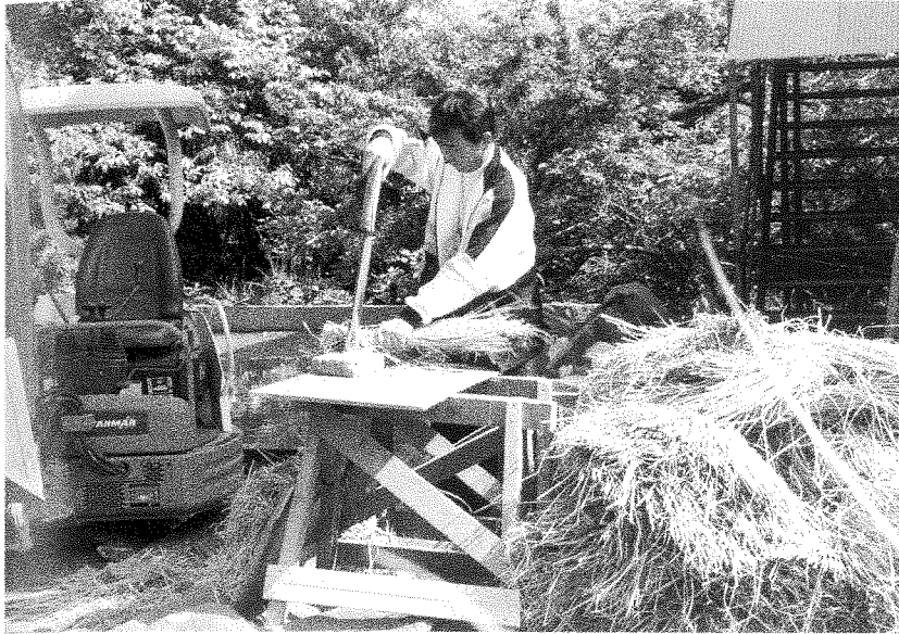
50 工事中 土 拵え 再生土のためのワラ切り
