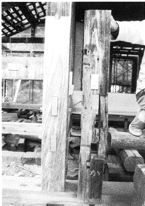
55 工事中 木 工 事 柱の根継（金輪継）
