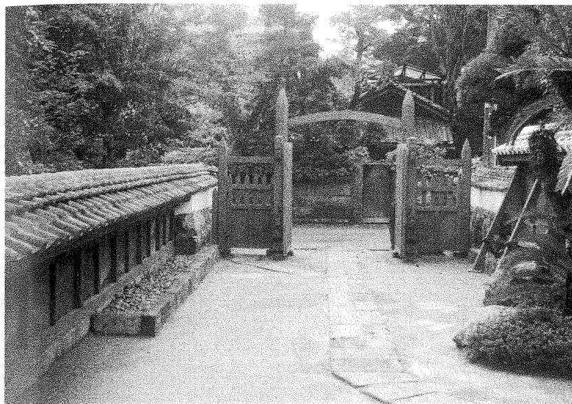
22 竣工 冠木門、板塀、土塀 敷地内より前面道路に向って
