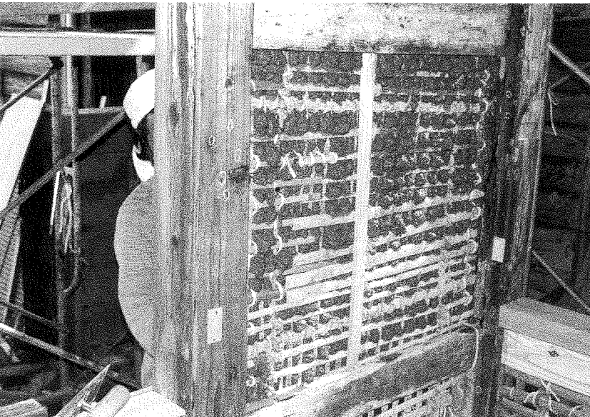
73 工事中 左官工事 荒壁塗り 壁裏状況
