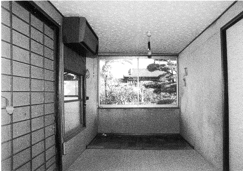
33 修理前 寢間東面を見る
