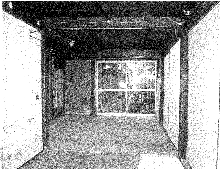
34 修理前 居間西面を見る
