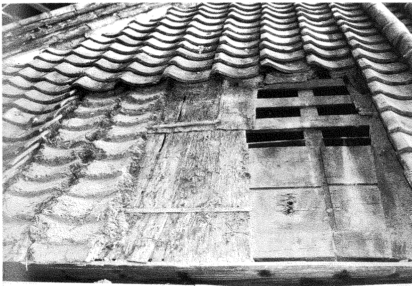
45 工事中 分解工事 屋根工法調査
