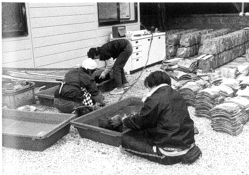
46 工事中 同 上 再用古瓦の水洗い清掃を行う
