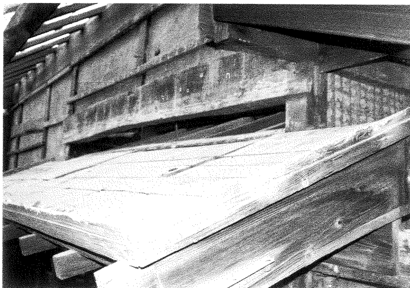
104 現状変更資料 佛間外縁上部に残る底 当初の玄関庇が解る
