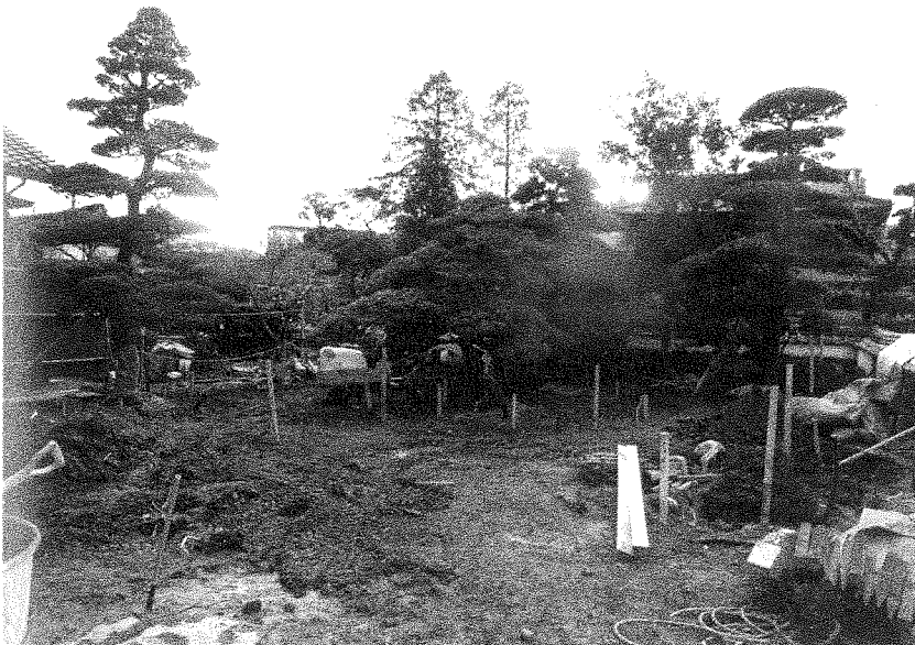
88 工事中 庭 工 事
