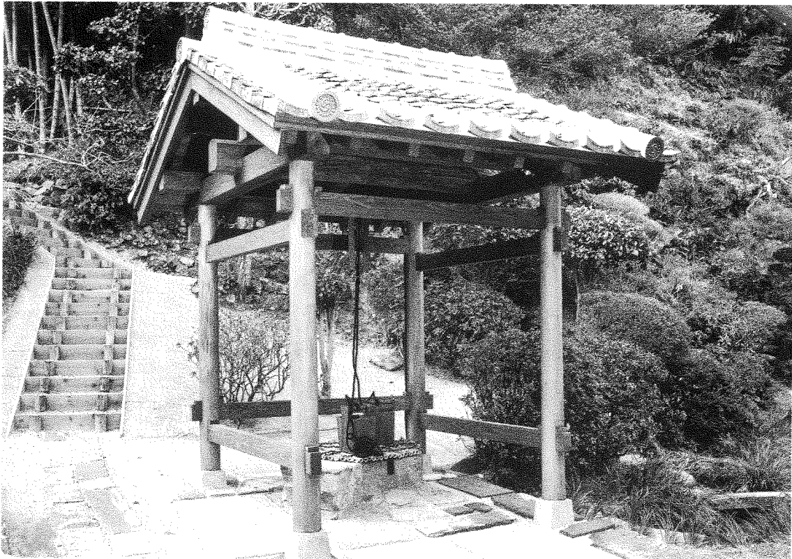
18 竣工 井戸屋形外観
