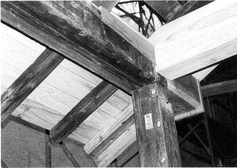
59 工事中 木工事 破損、腐朽部の取り替え及び繕い
