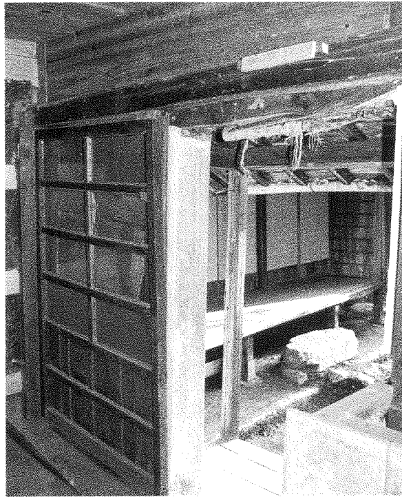
124 修理前 土蔵 内部 一階出入口を見る
