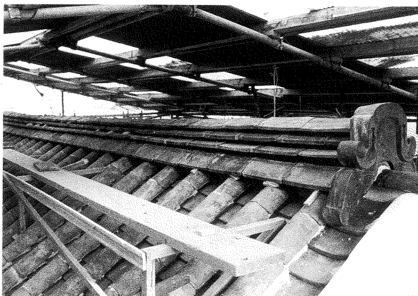
133 工事中 土蔵 屋根工事 本瓦葺き完了
