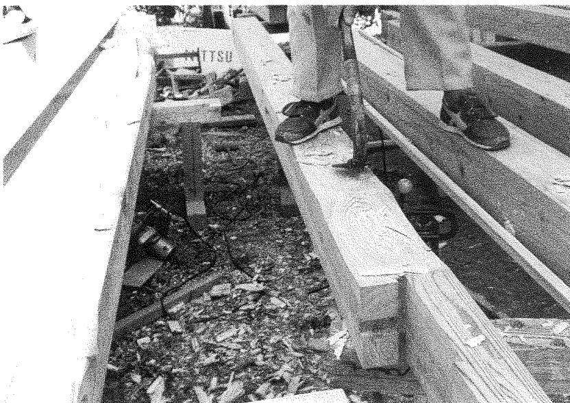
54 工事中 木 工 事 木材加工 土台下端の礎石ひかり付け
