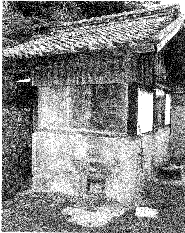
139 修理前 風呂場棟 外 観
