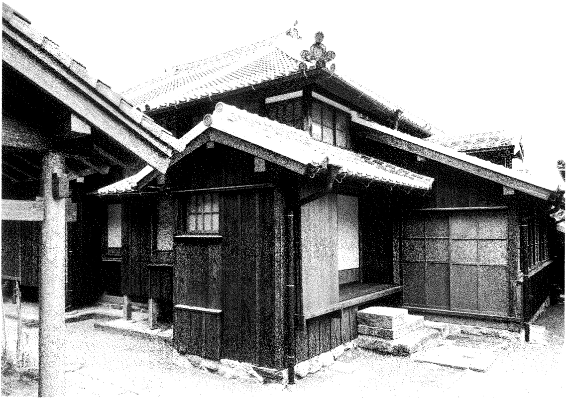
2 竣工 南 西 面 台所出入口附近
