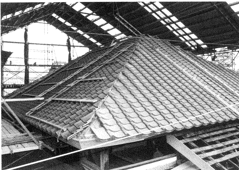
67 工事中 屋根工事 棧瓦の葺き上がり
