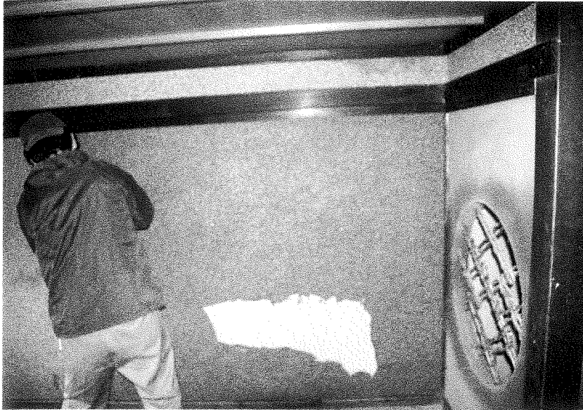
80 工事中 左官工事 砂壁上塗り施工中
