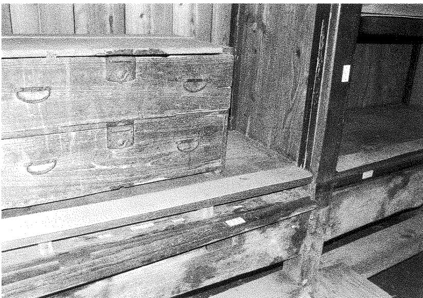
103 現状変更資料 佛間(ち)通り柱埋木下部に貫穴、 間渡し竹穴と足固め上部に間柱貫 穴・縦間渡し竹穴の痕跡有 当初は壁面だった
