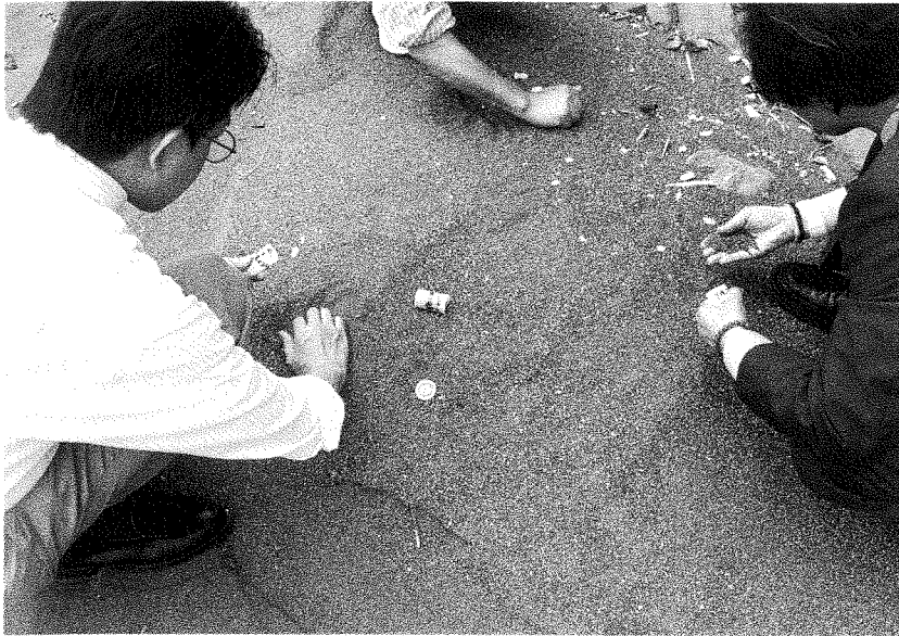
74 工事中 左官工事 壁砂採取 蒲江高山海岸にて
