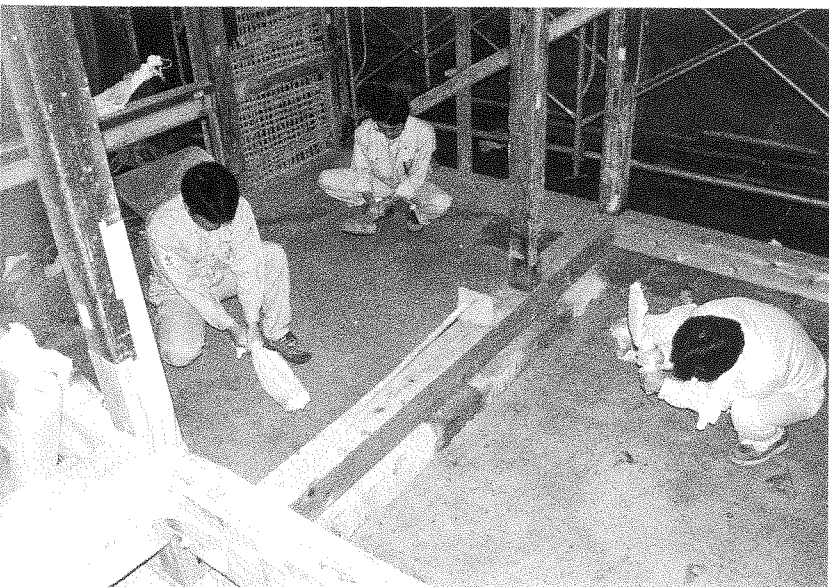
64 工事中 土間叩き 床下も三和土の叩きで仕上げた
