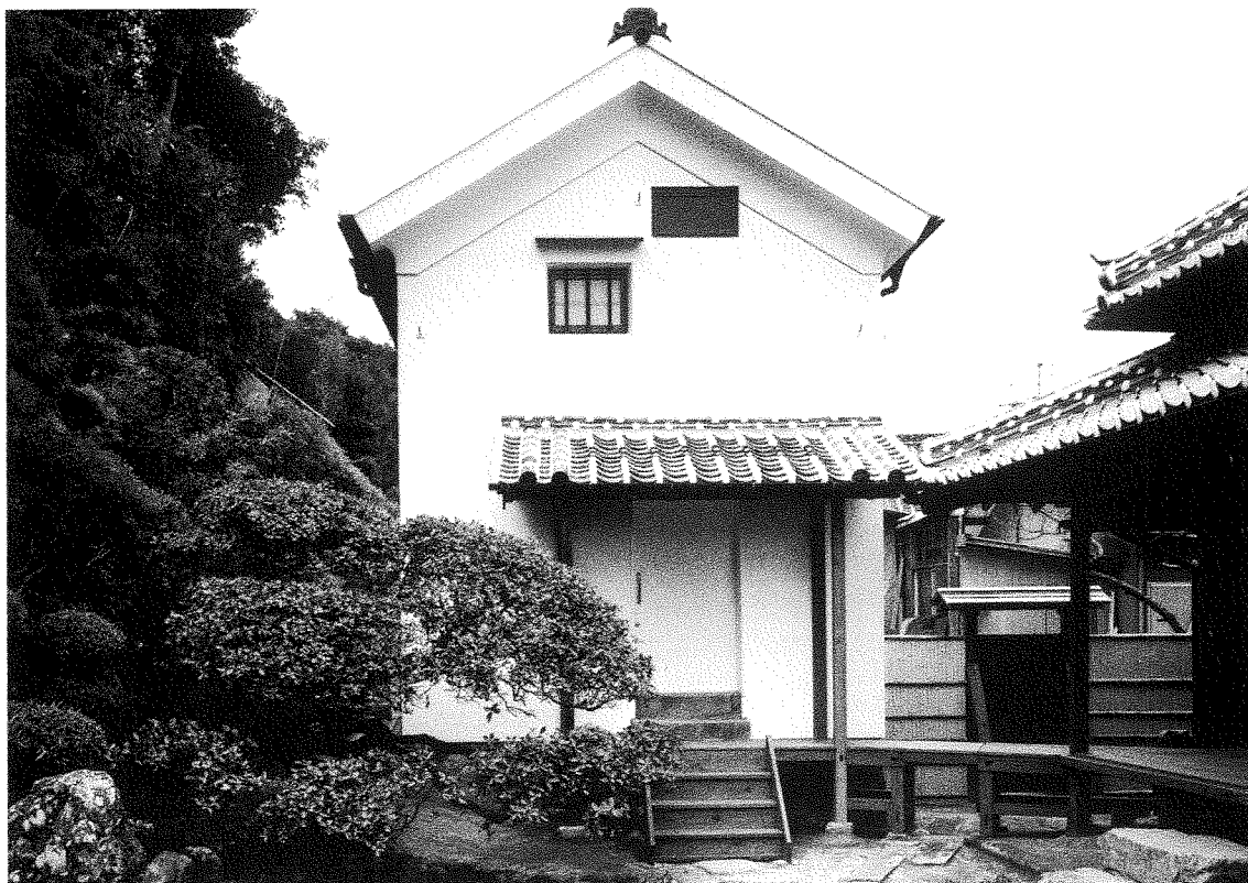
15 竣工 外観正面
