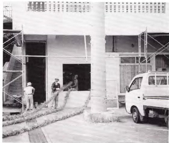
写真 2-4 完成した網の収納の様子
