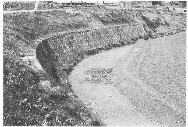
D区終了状況
