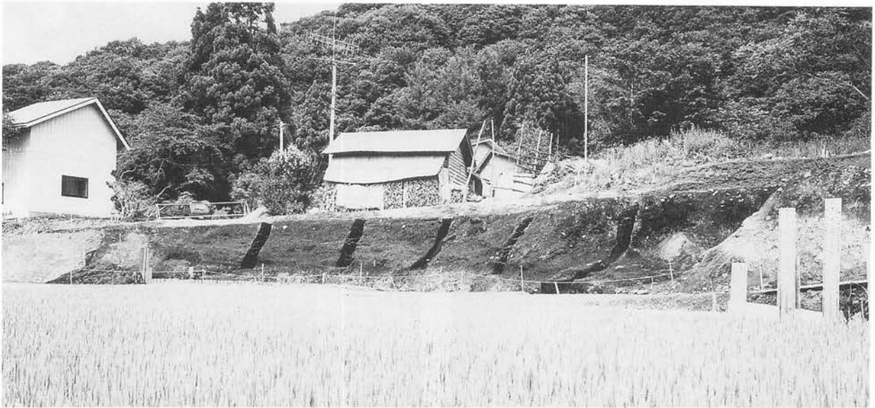
包含層露出状況
