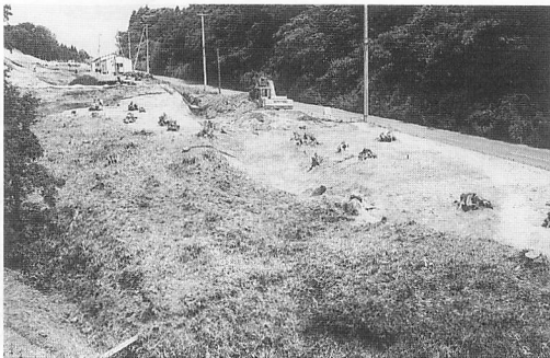
F区調査終了全景 SW→
