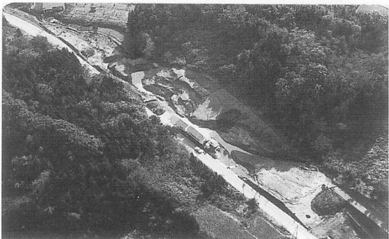
平成7年度調査終了全景 E →
