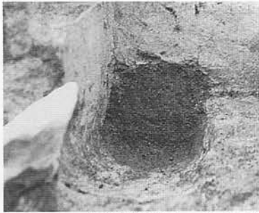
煙道部横断面 (西から)
