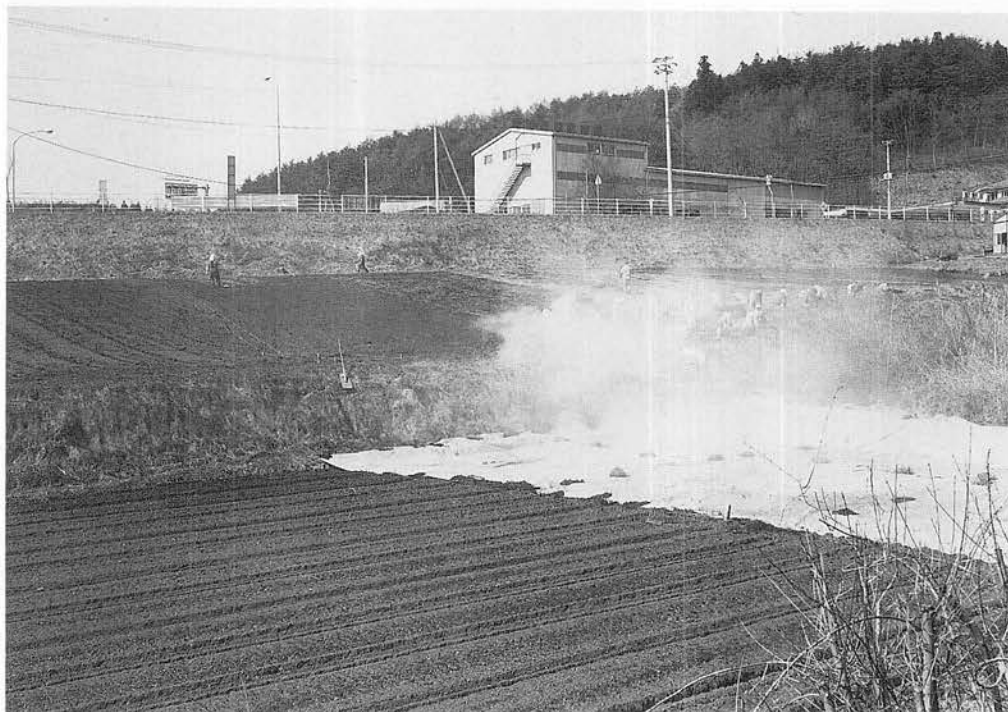
平成2年度調査区全景（東より）
