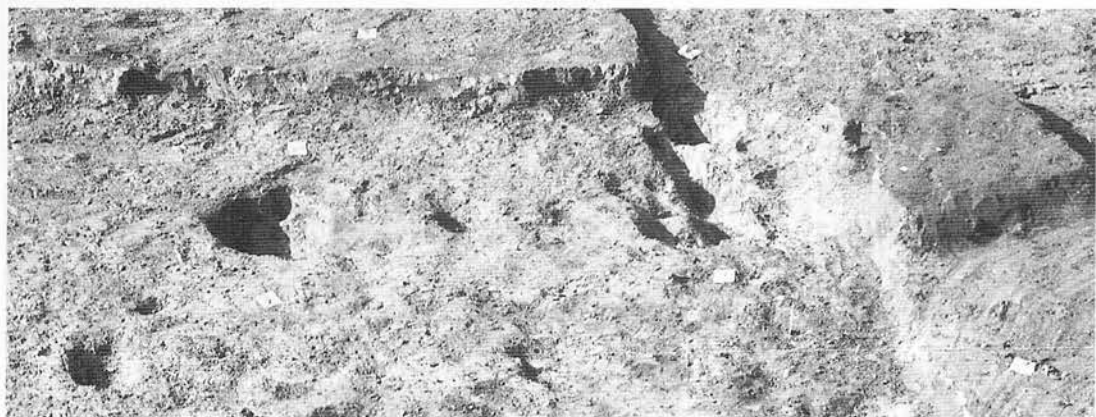
床面土坑の状況
