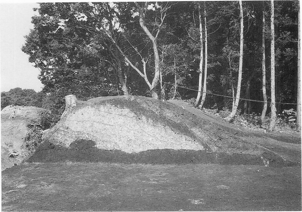
3号堀東側土壘断面（南から）
