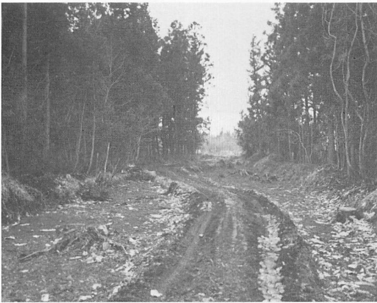
B-44付近調査前（東から）
