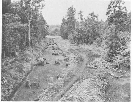
B-36付近調査前（東から）
