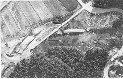
西端部調査区全景
