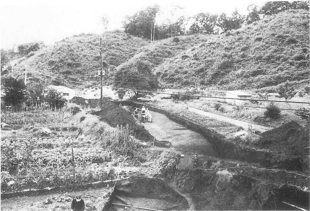
近景（北東から）
