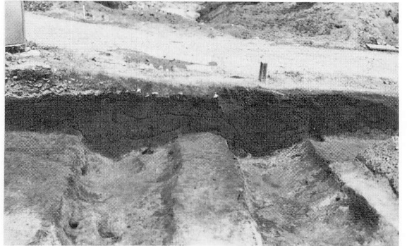
2号・3号溝断面(南から)
