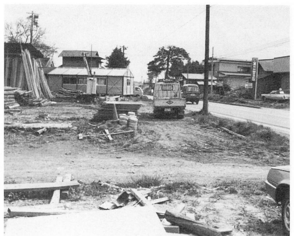
南日詰遺跡南側区域調査前(北から)
