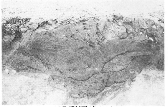
10号溝断面(北から)
