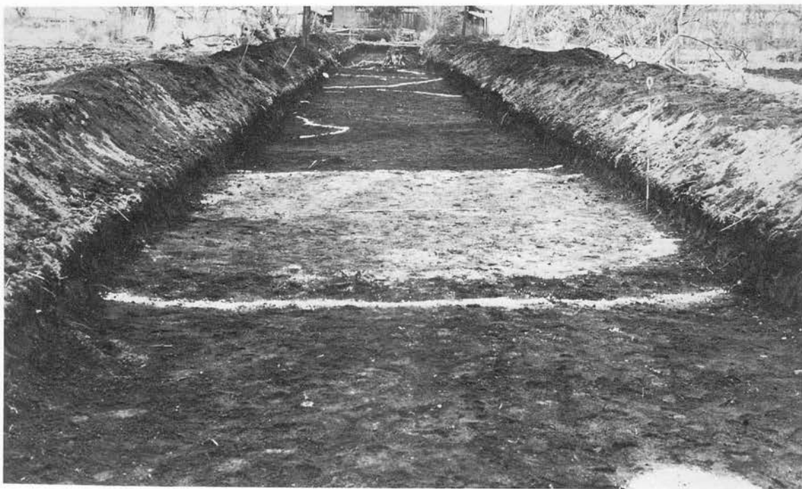
a. 試掘調査状況
