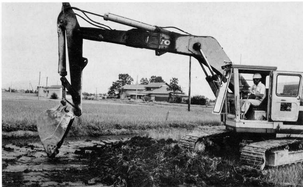
A・重機による粗掘り作業
