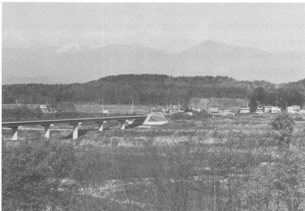
A. 遺跡遠景（工事完了後）
