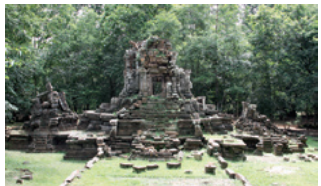
図15 三祠堂修復前（東から）
