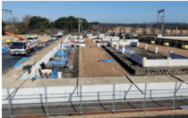
図66 修繕工事中の兵庫県（南から）
