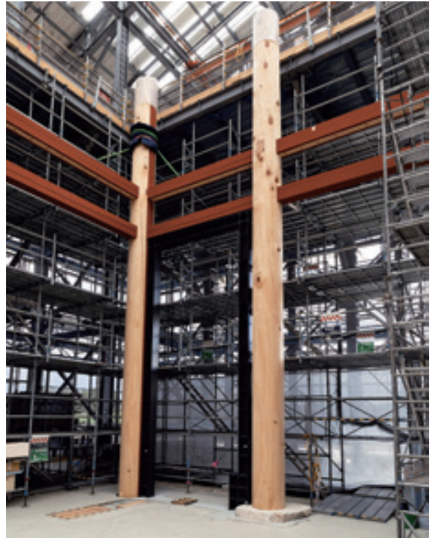
図59 東楼側柱の掘立柱（ニー）と礎石建ちの柱（ハー） （2023年9月7日撮影・南西から）
