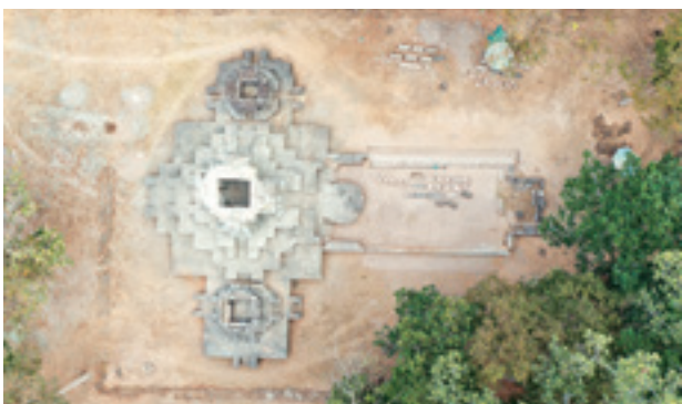
図14 三祠堂修復後俯瞰写真（上空から、上が北）
