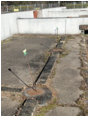
図63 木柱撤去後の回廊（南から）
