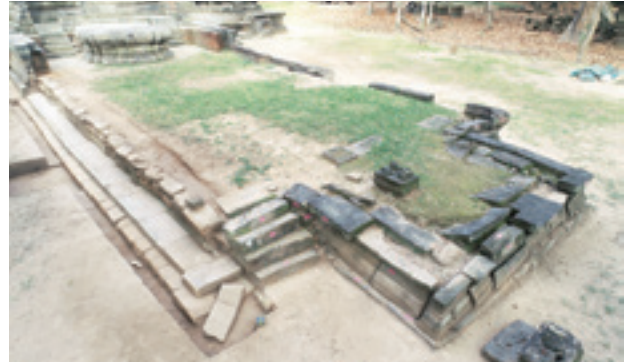
図19 東テラス南壁修復中（南東から）
