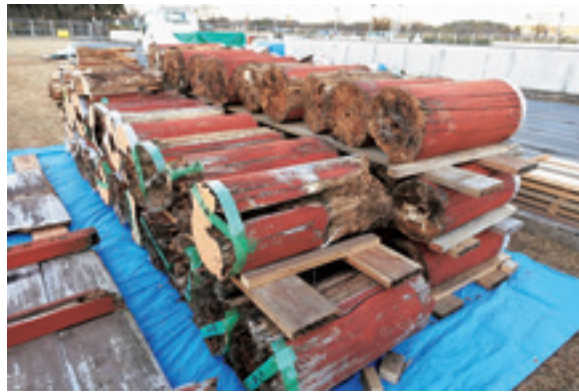
図64 撤去された木柱
