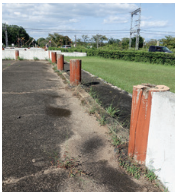
図62 修繕工事前の兵部省（南から）
