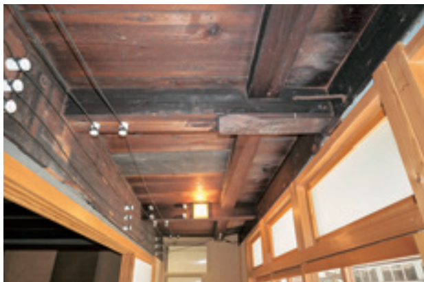
図24 正面下屋上部の土居桁（物件番号15）
