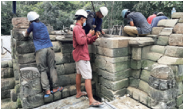
図16 中央祠堂再構築作業風景（北東から）
