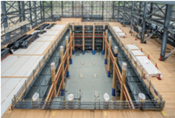
図57 東楼側柱建方 東楼棟通りを中心とした全景 （2023年9月7日撮影・東から）
