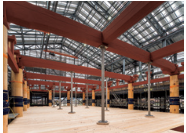
図61 東楼上層内部（2024年1月31日撮影・北西から）
