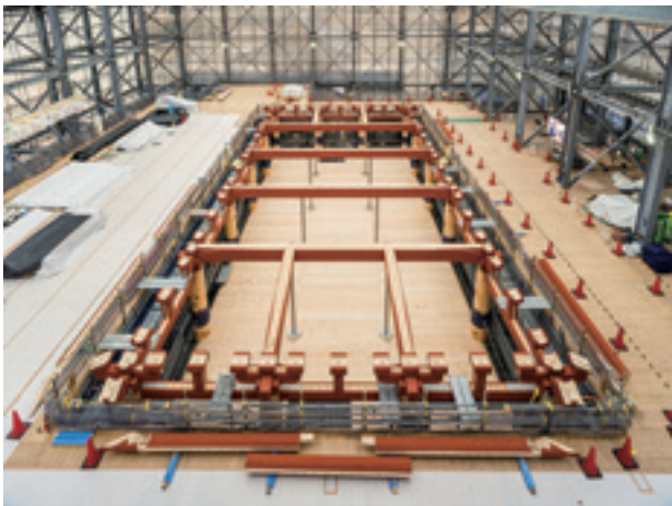
図58 東楼側柱上丸桁受斗 東楼棟通りを中心とした全景 （2024年1月31日撮影・東から）
