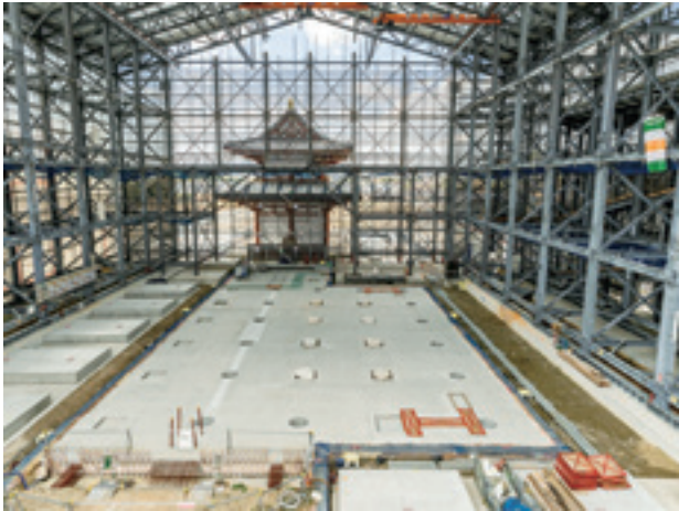
図56 東楼側柱（掘立柱）据付穴・内部柱礎石据付 東楼棟通りを中心とした全景（2023年1月20日撮影・東から）
