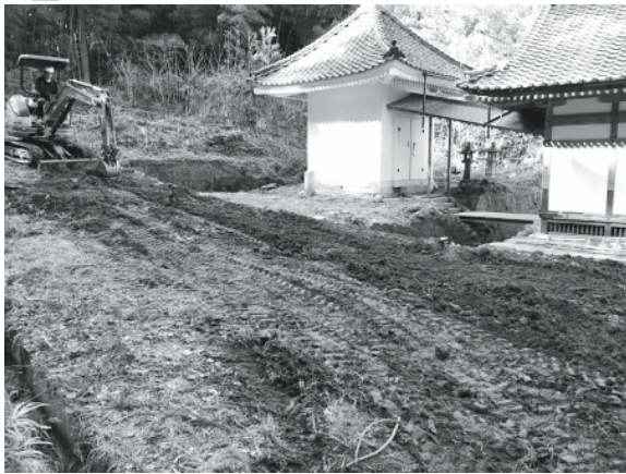
石造物の地中保管作業完了状況（拝殿南側）
