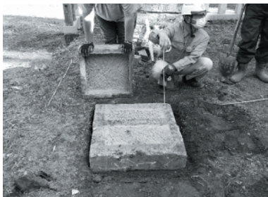
1 下段基礎の設置
