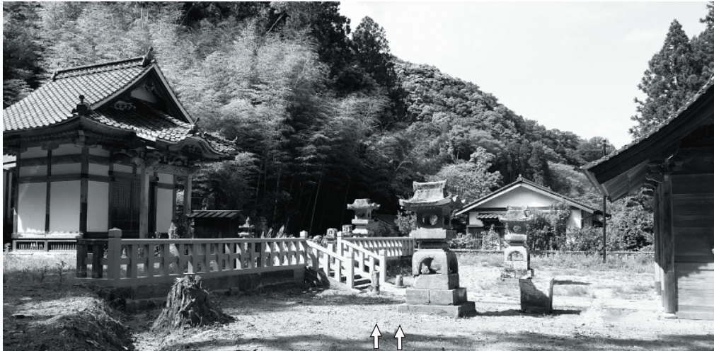
中之段の状況：左の上段に拜殿、中之段右手に随神門。上段に登る階段の手前に石造鳥居の根元が元位置に残る（矢印の場所）
