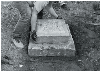
2 上段基礎の設置
